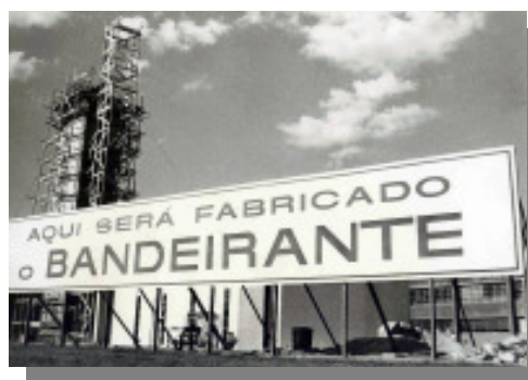
Início das obras de construção da Embraer
